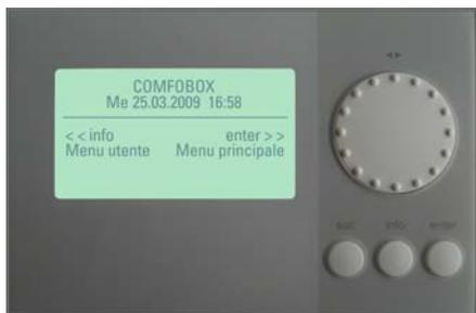
Fig. 8 Dispositivo di comando ComfoBox (riscaldamento, raffreddamento, acqua calda)
